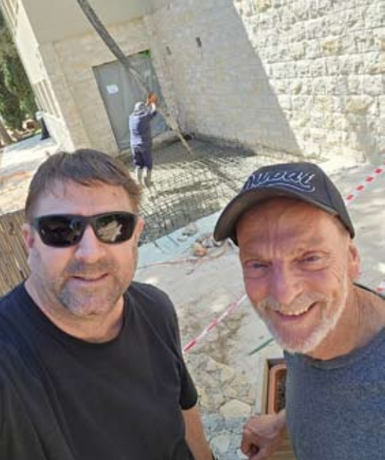
Johannes Ben Jaar ja Itai Meron uusien pommisuojiin rakennustyömaalla.
